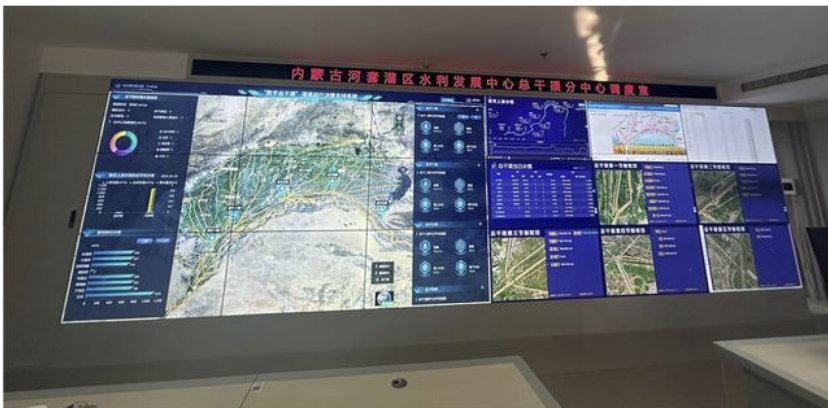
内蒙古河套灌区水利发展中心总干渠分中心调度室
